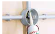
Si no utiliza prensaestopas, cierre todas las entradas de cable con sellador, para evitar la dispersión del producto
